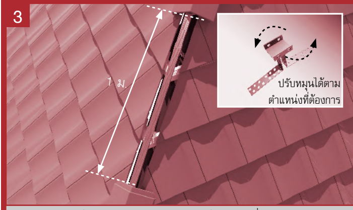
4 ติดตั้งขายึดเหล็กกับตะเข้ส้น ด้วยตะปูเกลียวยึดแปด้านละ 2 ตัว ที่หลังตะเข้ส้นให้ขายึดเหล็กห่างกันไม่เกิน 1 ม. และติดตั้งเหล็กปรับรอบกับขายึดเหล็ก ด้วยตะปูเกลียวยึดแปจำนวน 4 ตัว (ด้านละ 2 ตัว) ตรวจสอบระดับหลังเหล็กปรับรอบต้องแนบเสมอกับใต้ท้องกรอบสันโค้งพอดี
