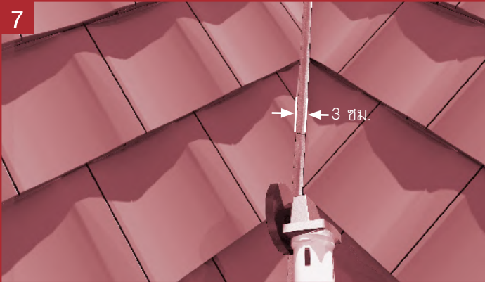
7 ตัดกระเบื้องตะเวีรางด้วยใบตัดคอนกรีต โดยให้ระยะห่างของแนวตัดประมาณ 3 ซม. ตัดให้ได้แนวตรงตลอดตะเวีราง ขณะตัดกระเบื้องด้วยใบตัดคอนกรีต ระวังใบตัดจะไปโดนรางน้ำจนทะลุจะทำให้เกิดการรั่วซึม
