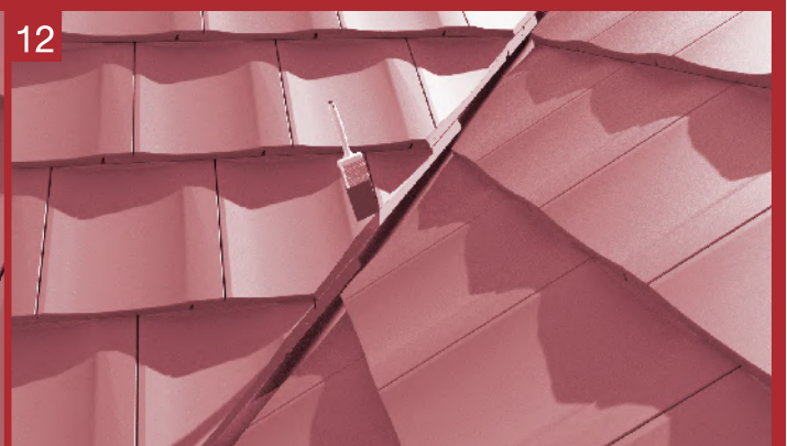
12 ต้องใส่กระเบื้องพิเศษตรงรางน้ำให้ครบทุกแถวทั้ง 2 ด้าน และใช้ลิทากระเบื้องหลังคา เซรามิก เอสซีจี รุ่น เอ็กซ์เซลล่า เกรซ และโมเดิร์น ทาตรงบริเวณรอยตัดกระเบื้อง ให้เรียบร้อยเพื่อความสวยงาม แต่อย่าให้เลอะบนหลังกระเบื้อง
